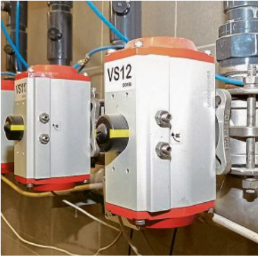
VA-Strangventile halten die höheren Drücke problemlos aus und verkleinern den Leitungsquerschnitt nicht.
