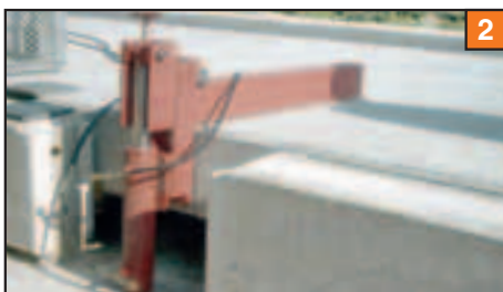
Anheben der Wiegebrücke mit Spezialhebewerkzeug
