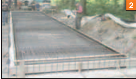
Fertige Bewehrung - Brücke bereit zum Betonieren
