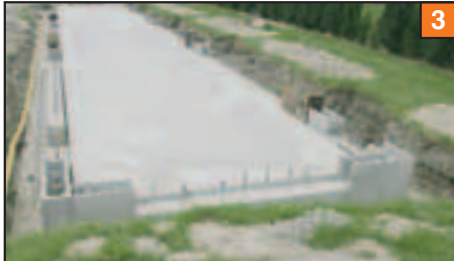
Erstellung der seitlichen Randmauern (Hier mit Betonschalsteinen)
