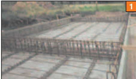
Untere Bewehrung und Korbkonstruktion. (Blindbalken für Brückenauflegepunkte)
