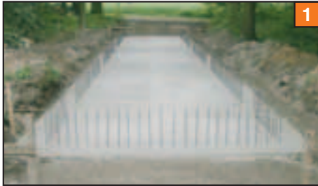
Fundamentplatte und Anschlußbeisen für seitliche Randmauer
